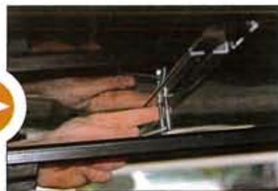
**09** È il momento di inserire le staffe di fissaggio (a forma di cavallotto) della tenda dentro le apposite guide. Le si fa scorrere fino alla barra, poi si solleva leggermente la tenda per posizionare la "U" rovesciata a cavallo della barra stessa.
